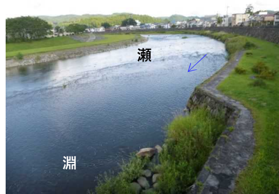
◀景観と生態系に配慮した横手川(横手市)▶
