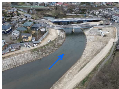
太平川(秋田市) 《橋梁架替工事(才八橋)》
