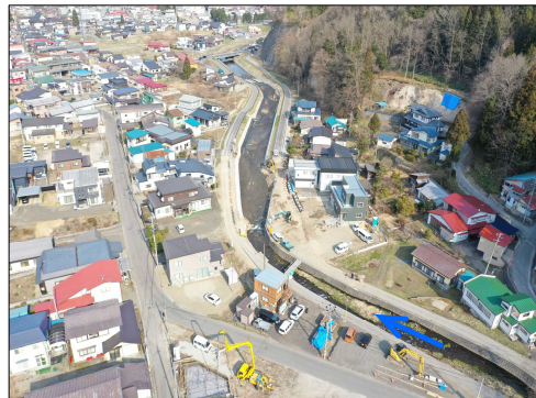
福士川(鹿角市) 《河道掘削・護岸工事》
