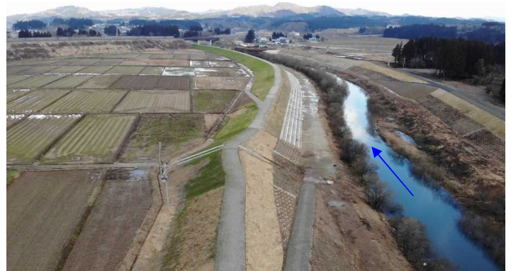
復旧工事完了
